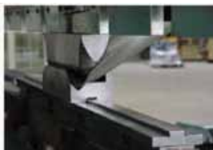
Предварительная гибка кромок на гибочном прессе
